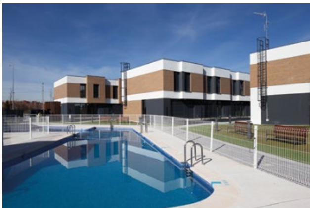
La iniciativa alcanza a 160 viviendas unifamiliares de nueva construcción en Torrejón de Ardoz (Madrid).
