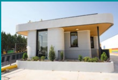
Su construcción ha supuesto una reducción del tiempo de obra respecto a los métodos tradicionales.
